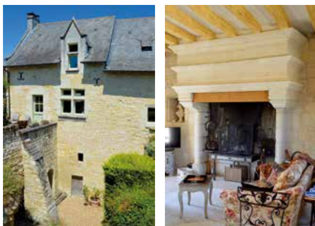
Dans un village au sud de la Loire, un logis du 15ème siècle avec sa dépendance aménagée, son jardin et sa cour troglodyte 450 000 € Ref 922749
