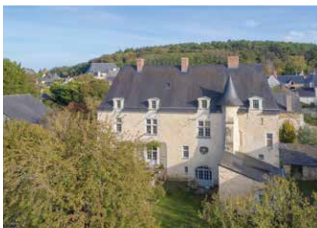
Entre Angers et Saumur, dans un village du baugeois, un manoir du début 17ème siècle à la très riche histoire 1195 000 € Ref 378588
